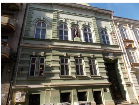
înainte de renovare
